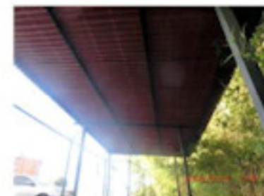
大屋根の完成 (11月)
