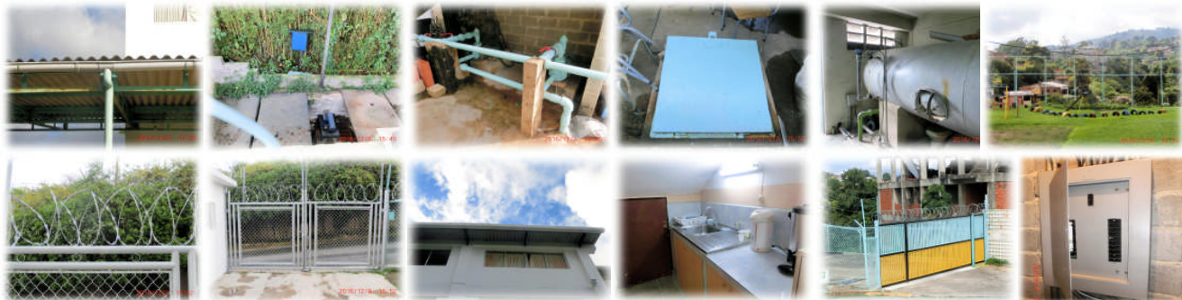
(写真上段左から：②雨樋、③⑤⑥汚水槽と汚水ポンプ、⑦上水道パイプ、⑦上水道タンクの蓋、⑦上水道タンク、⑨外周フェンス
