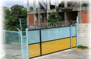
11月24日 校舎周りのフェンスの改修工事をしました！
