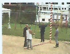
Instalando el arco de entrada
